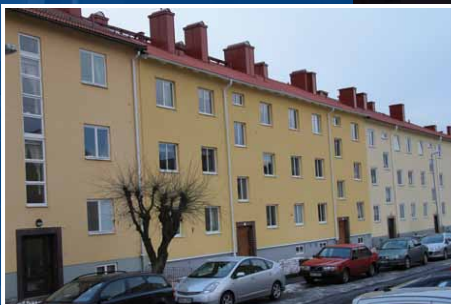
Fasadrenovering, fönsterbyte och nyläggning av tak.
