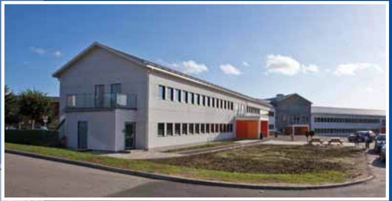
Karl-Oskarskolan i Växjö är en stor del av den renovering vi genomför i Fläckfabrikens tidigare domäner.
