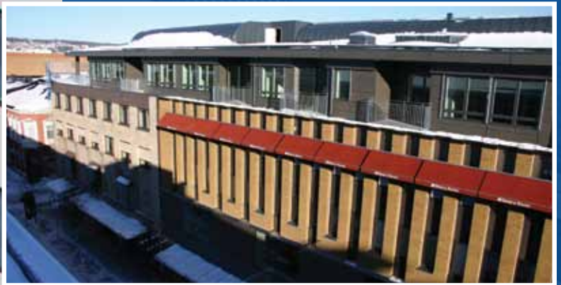
Kontors- och butikslokaler i Jönköping där vi också byggt lägenheter ovanpå.
